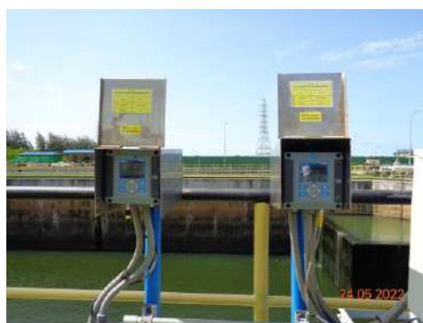
ภาพที่ 2.2-15 ระบบตรวจวัดน้ำทิ้งแบบอัตโนมัติ
